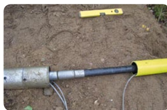
Kuva 29. Tripla-putken kiinnitys myyrään
