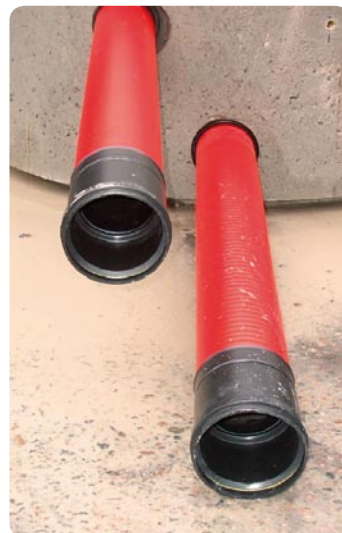
Kuva 19. Triplan läpivienti betonikaivoon
