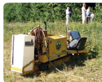
Kuva 34. Vaakaporaamalla tehty tienalitus 12 m
