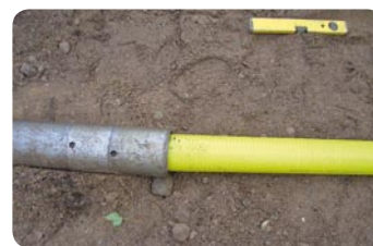
Kuva 30. Tripla-putken kiinnittäminen porauslaitteeseen
