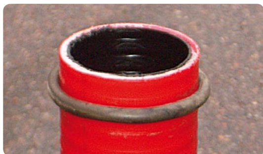
Kuva 20. O-rengas tiivisteiden paikka Triplan pistopäässä
