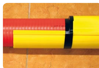
Kuvat 22 ja 23. Vaurioituneen Tripla-putken korjaaminen halkaistulla putkella.
