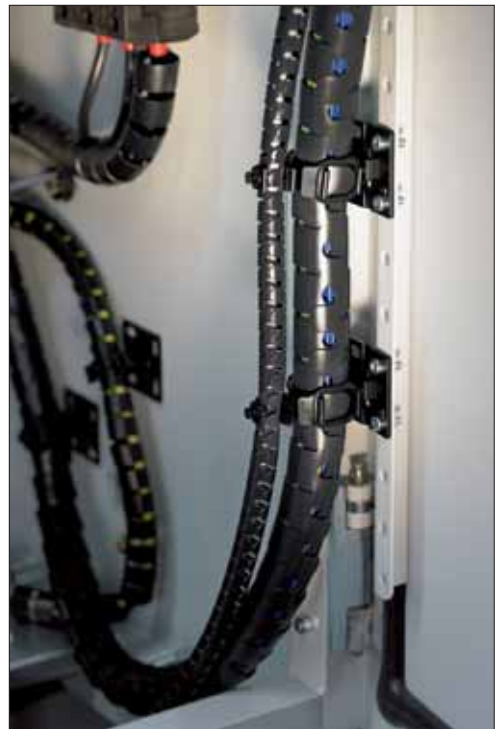
Helawrap lisätarvikkeilla sidontaspiraalin kiinnittäminen on vaivatonta.
