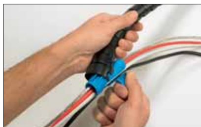
Aseta asennustyökalu Helawrap sidontaspiraalin toiseen päähän.
