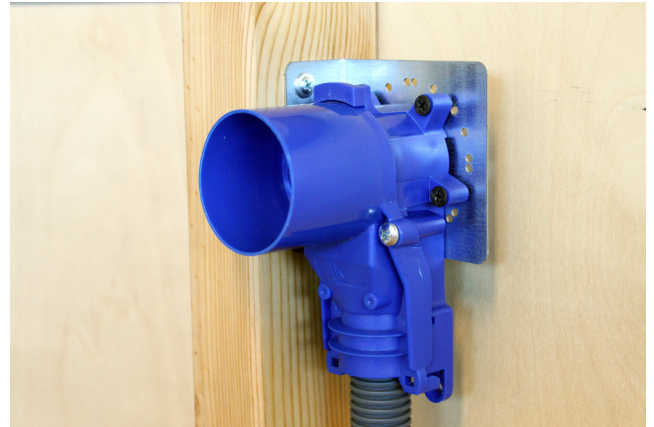
LK Hanakulmarasian kiinnike - 1 asennettuna seinän runkotolppaan.
