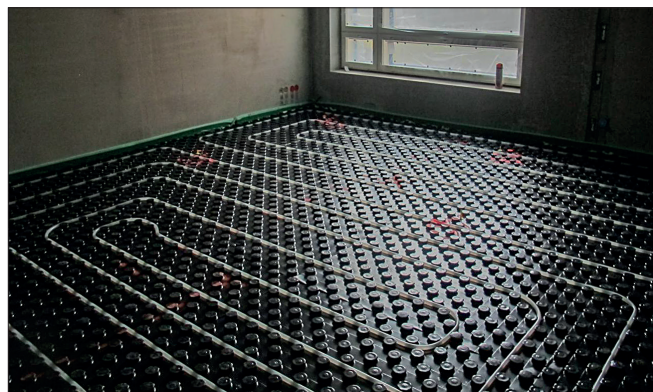
Lattialämmityslevyt ja -putkisto asennettu.
