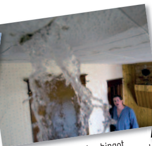
Putkikirikosta aiheutuvat vahingot
