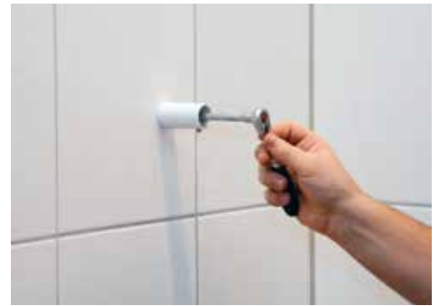
Asenna ja kiristä seinäankkurit.
