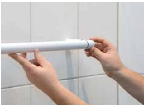
Aseta kahva kahteen asennettuun seinäankkuriin.
