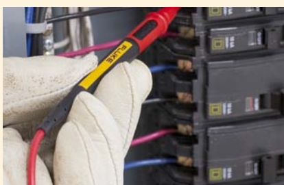
Valitse lyhyempi kärjen pituus CAT III -luokan mittauksiin
