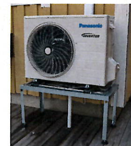
4. Montare le traverse e regolarle in base alla pompa di calore.
