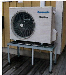
4. Asenna poikkipalkit ja säädä ne lämpöpumpulle sopivaksi.
