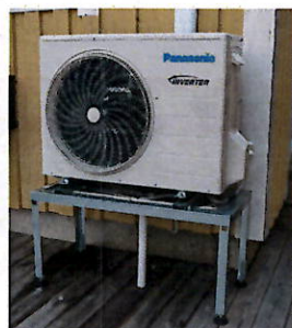
4. Montera på tvärstagen anpassat till din värmepump.
