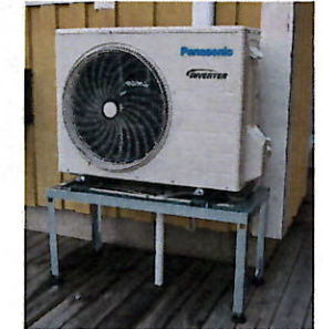
4. Monte as travessas e ajuste à sua bomba de calor.
