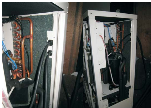
8. Syötä sisäyksikön virtakaapeli takaseinän läpiviennin läpi, ja kytke johtimet ulkoyksikön liitinrimaan.
