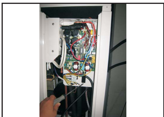
9. Kiristä liitokset ja vedonpoistin huolellisesti.
