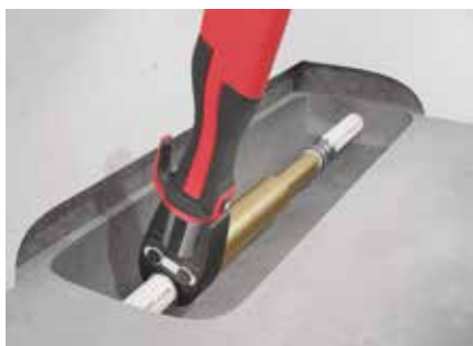
Kuva 30: Korjausliittimien asennusvaiheet.
