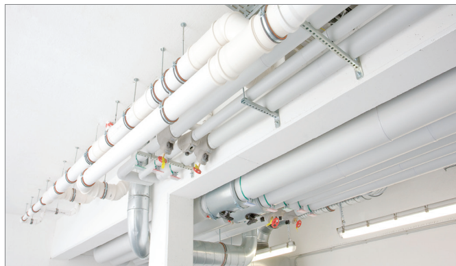
RAUPIANO PLUS asennettuna
