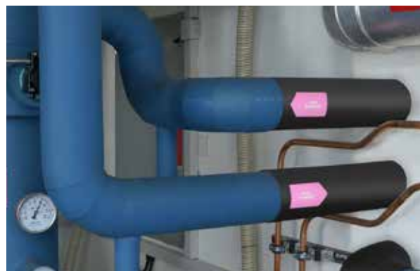
Ainutlaatuinen ArmaFlex Protect -palontorjuntaratkaisu varmistaa tehokkaan lämmöneristyksen, luotettavan kondenssin hallinnan ja runkoäänien vaimennuksen samassa tuotteessa.
