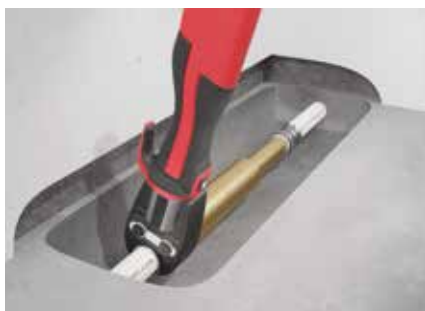
Kuva 30: Korjausliittimien asennusvaiheet.
