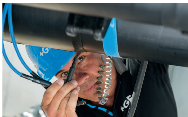
Yhdistä hitsauskaapelit liittimen hitsausnastoihin ja hitsaa käyttöohjeiden mukaan.
