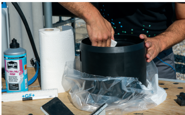
Pyyhi liittimen ja putkien hitsauspinnat puhtaiksi Tangit PE-puhdistusaineen ja puhtaalla liinan avulla.
