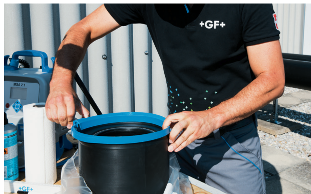
Sijoita asennuksen aputyökalu liittimen päälle. Venytä tiivistehuulta painamalla kahvoja toisiaan päin.
