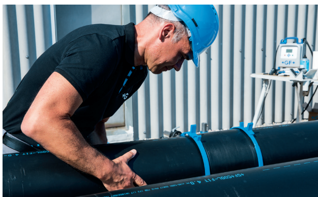
Työnä molemman putken päät liittimen sisälle aina upotusvyvyttä osoittavaan merkintään asti. Poista asennuksen aputyökalu.
