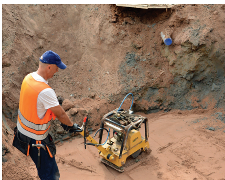
Tasoita ja tiivistä asennuskaivannon pohja huolellisesti.
