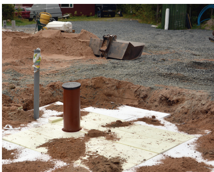
Eristä kaivanto ja viemäriputki routaeristelevyillä.
